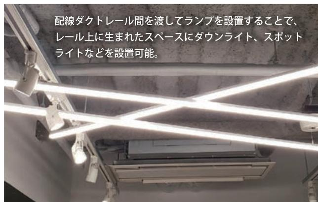
配線ダクトレール間を渡してランプを設置することで、レール上に生まれたスペースにダウンライト、スポットライトなどを設置可能。
